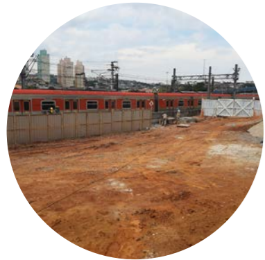
Terreno em obras / anexo bicicletário funcionários- Público (CPTM)
