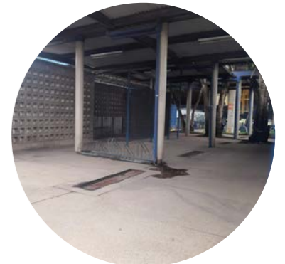
Bicicletário Terminal - Bicicletário desativado (Público)
